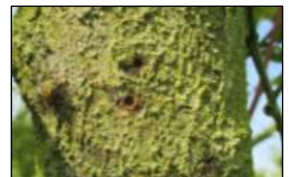
Perforations de xylébore (ssp) sur quetschier Photo : D. Lepage, FREDON Lorraine
