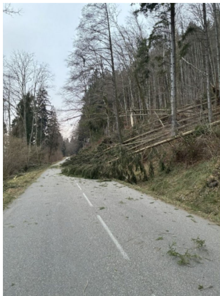
Dégâts causés par le vent sur l'agence de Schirmeck (© E. Degardin)
