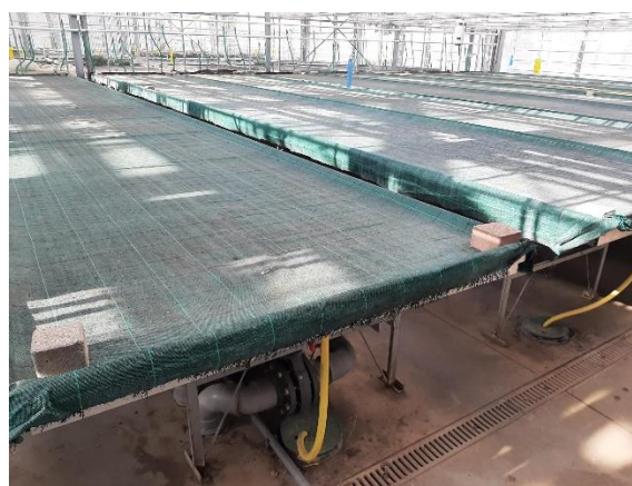
Serre vidée et nettoyée. Photo EH.
